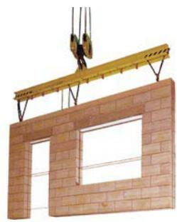
Um Beschädigungen des Wandelements beim Abheben von der Palette zu vermeiden, muss der Wandschwerpunkt des Elements unter dem Anhängepunkt der Traverse liegen, so dass das Element gleichmäßig angehoben werden kann. Die Schwerpunktausrichtung kann durch das Verschieben des Traversenaufhängeschlittens auch unter Last erfolgen.
