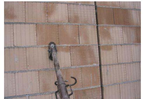
Bild 9: Montagefuge (vertikal)
